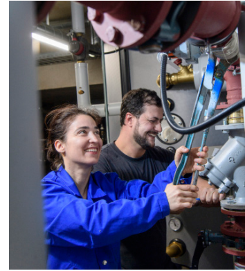
Quereinsteigerin erlernt den Beruf zur Heizungsinstallateurin EFZ
